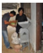
ภาพที่ 7 การติดตั้งเครื่องย่อดินผงและการทดลองใช้งาน
