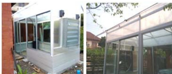
โรงเรือนต้นแบบระบบปิดสำหรับปลูกผักด้วยเทคนิค Hydroponics ที่มีกระบวนการควบคุมอุณหภูมิและความชื้นสัมพัทธ์ แบบEvaporative สำหรับบ้านพักอาศัย ขนาด 2 เมตร x 4 เมตร
