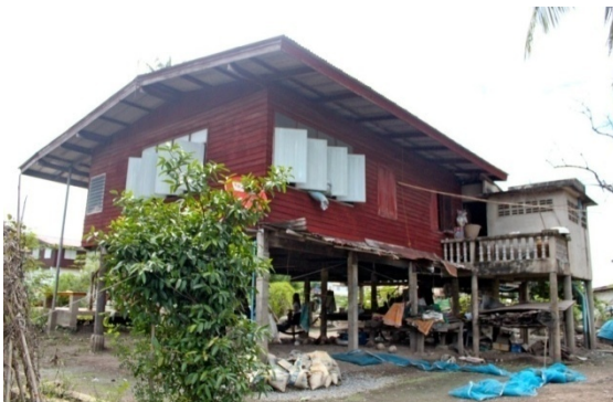
ภาพที่ 15 บริเวณโคนเสาจะมีฐานคอนกรีตรองรับเสาอยู่
