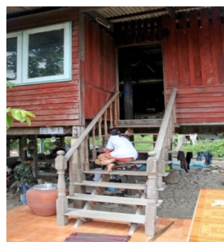
ภาพที่ 10 บันไดหน้าบ้านมีที่ล้างเท้า
