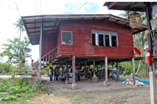
ภาพที่ 14 เสามีฐานคอนกรีตรองรับอยู่
