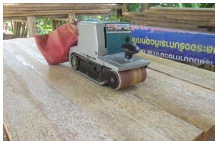
ภาพที่ 13 ขัดผิวพื้นไม้ปาล์มน้ำมัน
