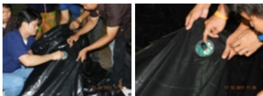
รูปที่ 5 แสดงการติดชุดส่งก๊าซ
