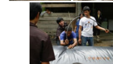
รูปที่ 9 แสดงการนำถุงลงหลุมและการเติมน้ำเข้าสู่ถุงหมัก
