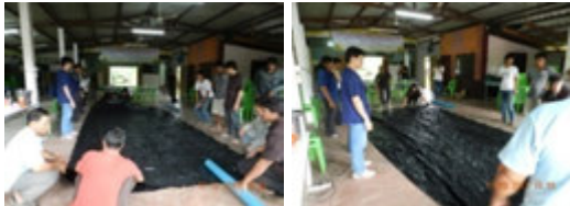
รูปที่ 4 แสดงถุงที่ทำทากาวและพร้อมในการติดตั้งชุดส่งก๊าซ
