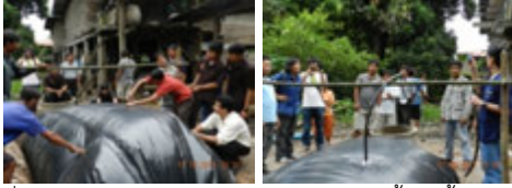
รูปที่ 11 แสดงการประกอบสายส่งก๊าซ พร้อมทั้งติดตั้งขวดปรับแรงดันและดักน้ำ
