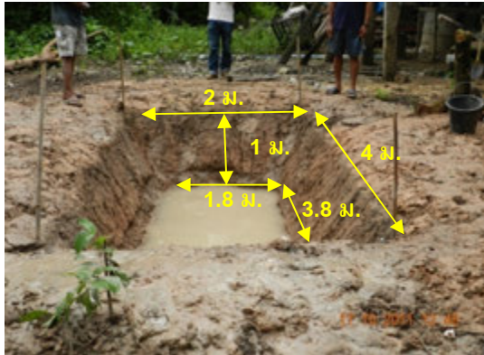
รูปที่ 3 แสดงการเตรียมพื้นที่สำหรับวางถุงหมักแก๊สชีวภาพ
