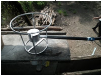
รูปที่ 12 แสดงการติดตั้งท่อส่งก๊าซและวาล์วควบคุมก๊าซ
