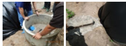
รูปที่ 10 แสดงการทำบ่อทางเข้าของมูลและบ่อล้นทางออก
