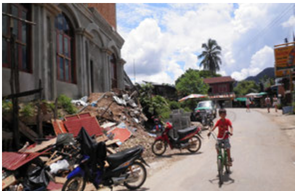
ภาพที่ 3 การสร้างอาคารโรงแรมในย่านกลางเมือง รุกล้ำพื้นที่ริมถนน
